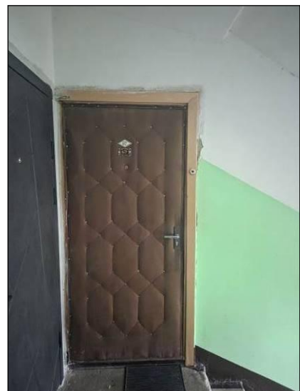
Kāpņu telpas (dzīvokļa ārdurvis)
